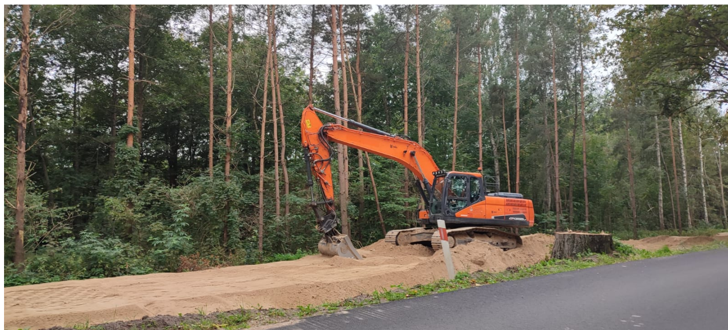
fot. Rozbudowa drogi wojewódzkiej nr 592 na odcinku Kętrzyn-Giżycko
