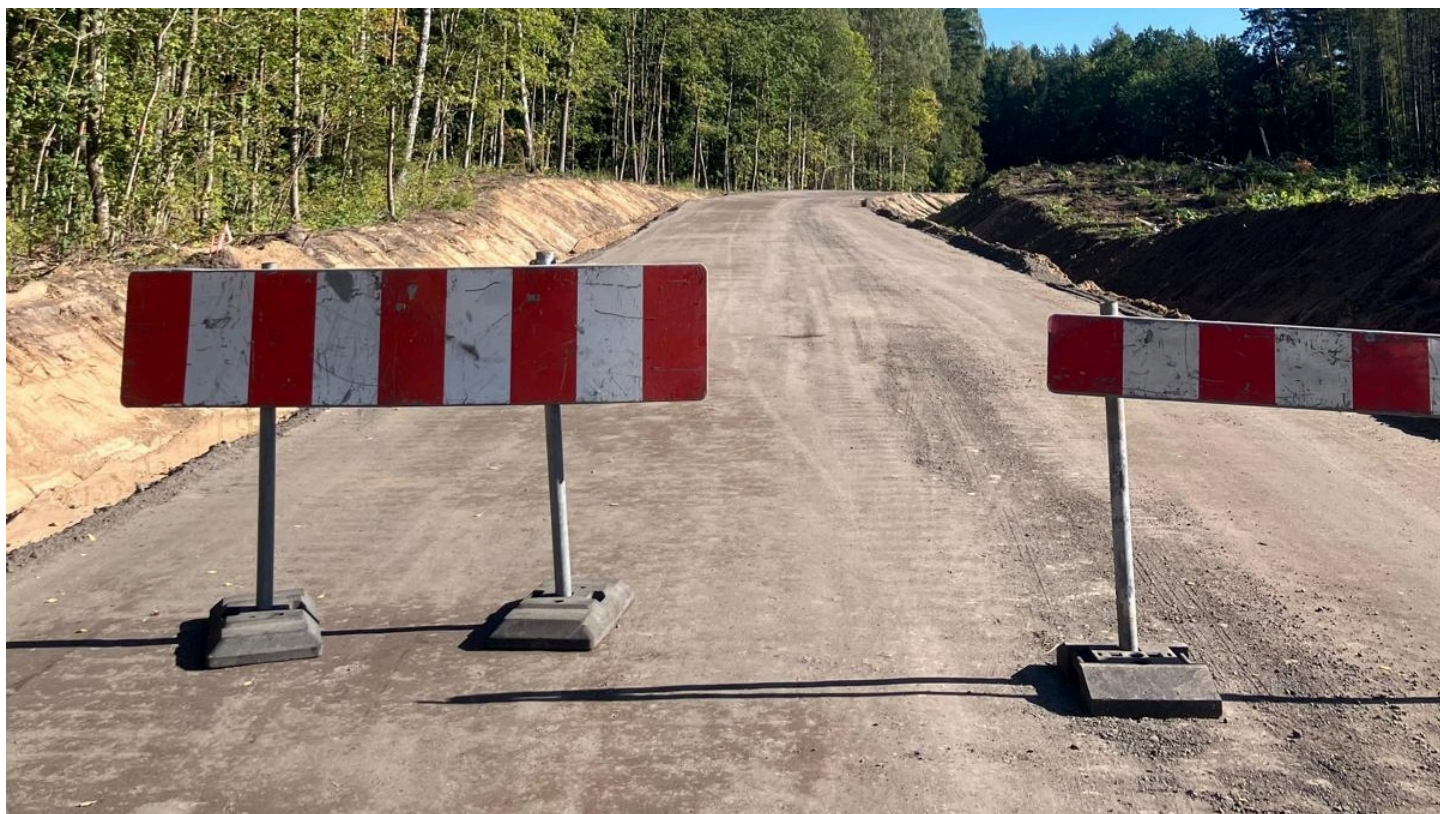
Fot. Facebook/Rozbudowa drogi wojewódzkiej nr 592 na odcinku Kętrzyn-Giżycko
