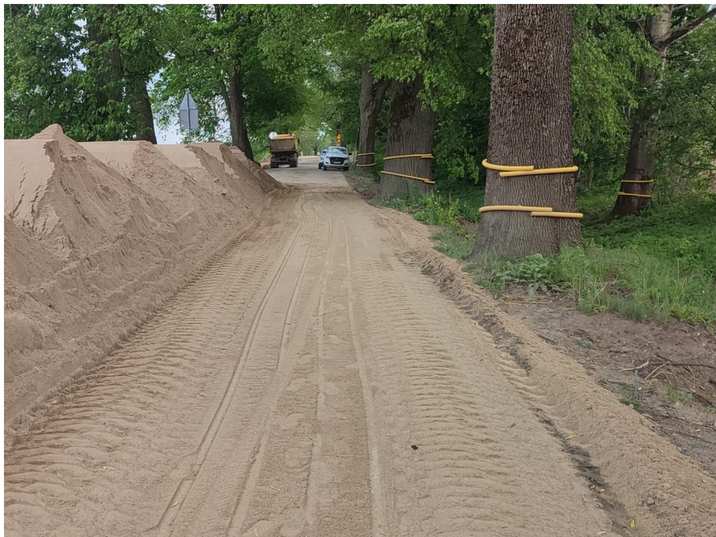
fot. Rozbudowa drogi wojewódzkiej nr 592 na odcinku Kętrzyn-Giżycko/Facebook
