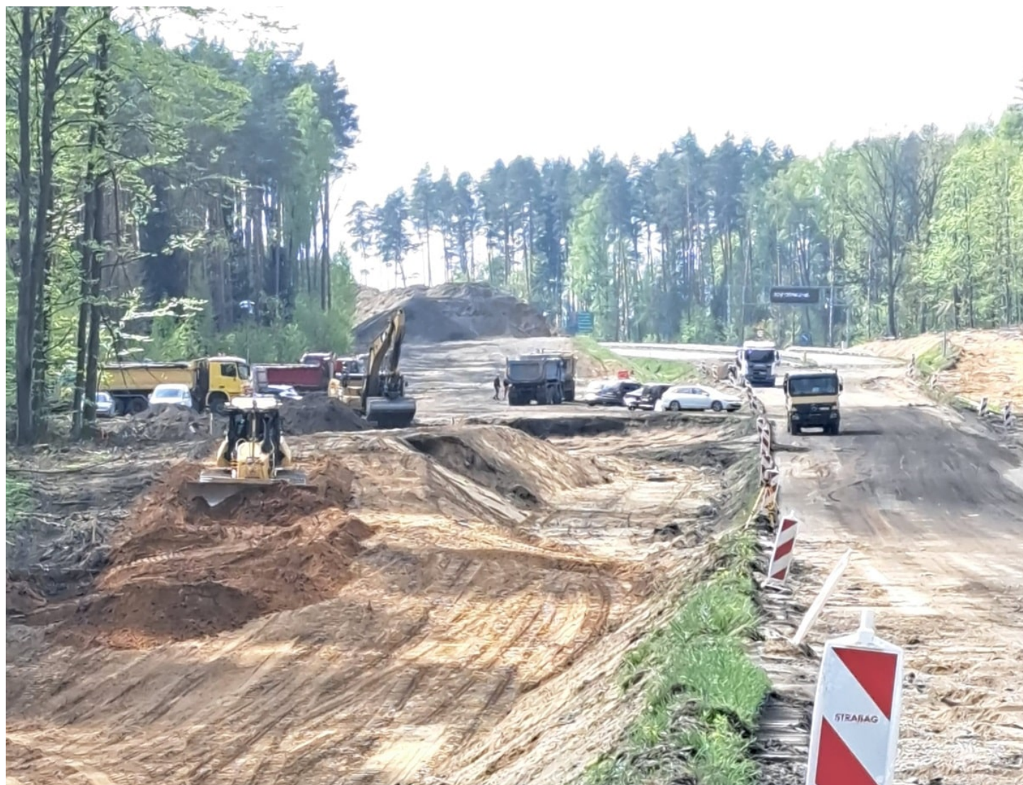
fot. Rozbudowa DW nr 527 od granicy m. Olsztyna do Węzła Olsztyn Południe/Facebook
